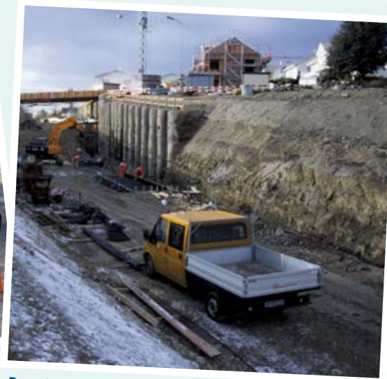
Bau einer neuen Straße
