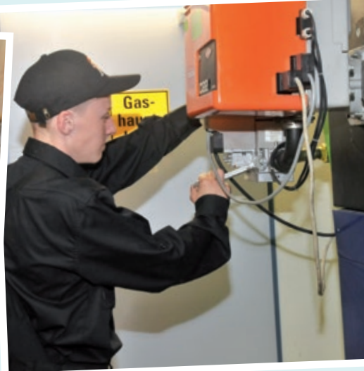
Service an einer Gasheizungsanlage
