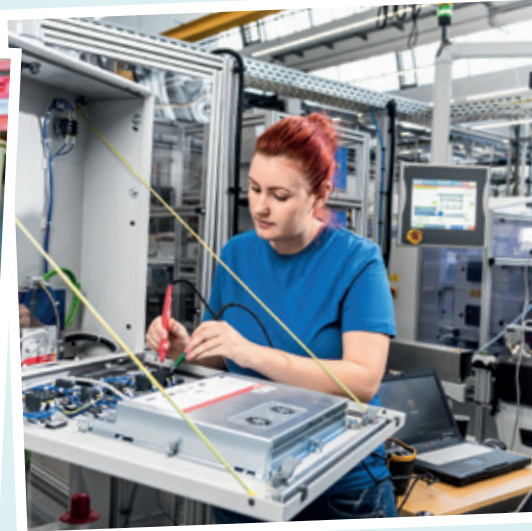
Fehlerquellen am Steuerungsgerät suchen
