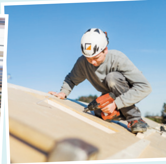
Montagearbeiten am Dach
