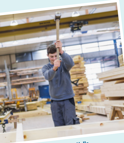
Abbundarbeiten in der Halle
