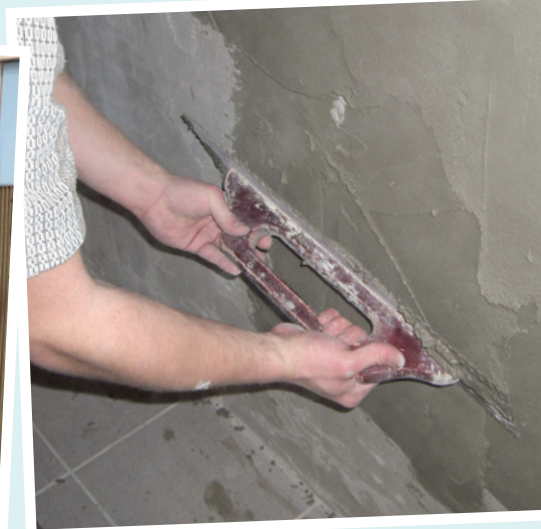
Grundierung auftragen
