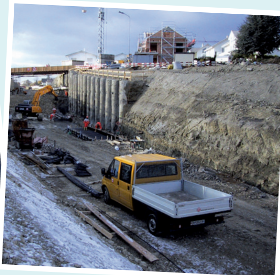
Bau einer neuen Straße
