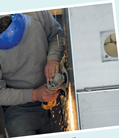
die Schweißnaht schleifen
