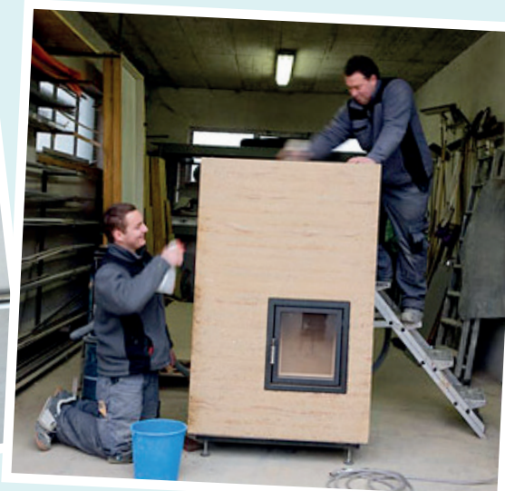
Befeuchten des Lehmverputzes
