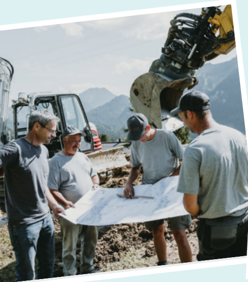
auf der Baustelle
