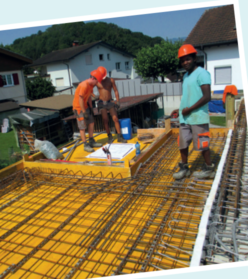
Baustahlgitter auslegen
